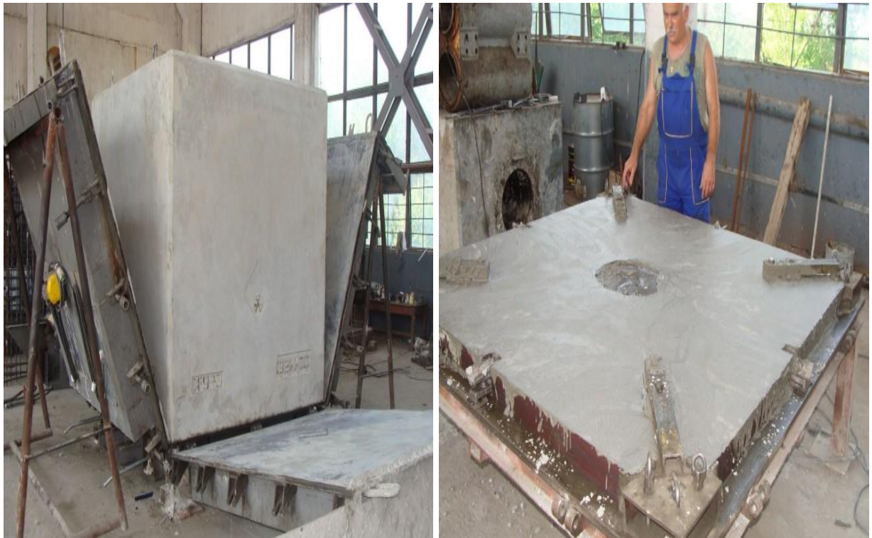
Фигура 4: Изработване на стоманобетонов контейнер
