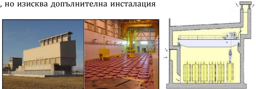
Фиг. 8. Общ вид на хранилище за сухо съхранение на отработено ядрено гориво
