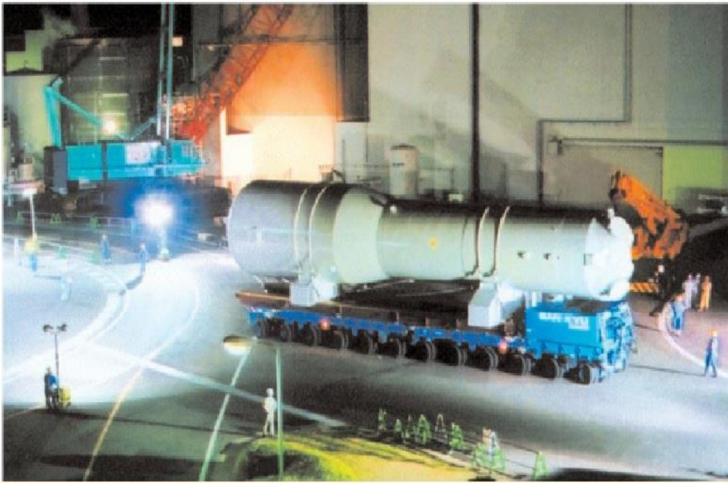
Пристигане на ПГ на площадката на ЯЕЦ (вертикален парогенератор)
